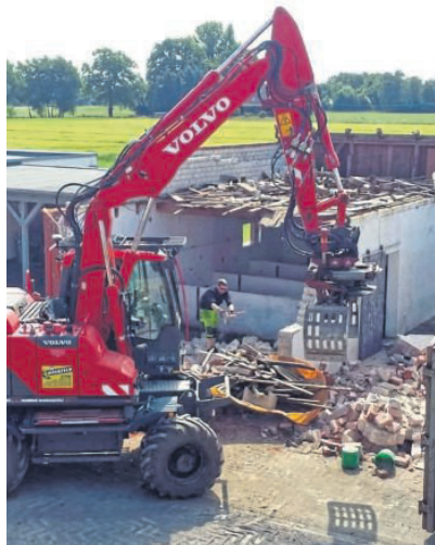
Auch Abbrucharbeiten gehören zum Leistungsspektrum des Heiligenroder Familienbetriebes.
