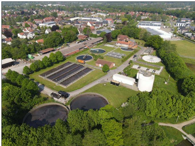
Station 9_Klärwerk Diepholz
